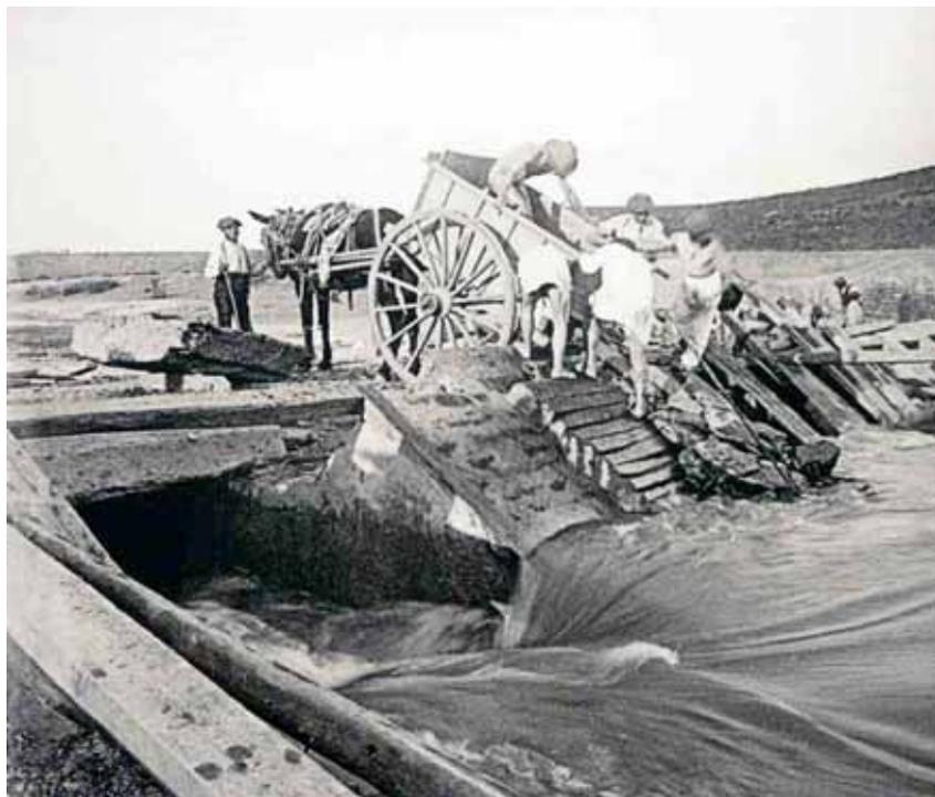
Fig. 5.- Fotografía de las obras. El material se transportaba con los medios de la época, principalmente carros arrastrados por mulas.
